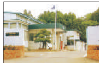
宮城田尻第一工場
